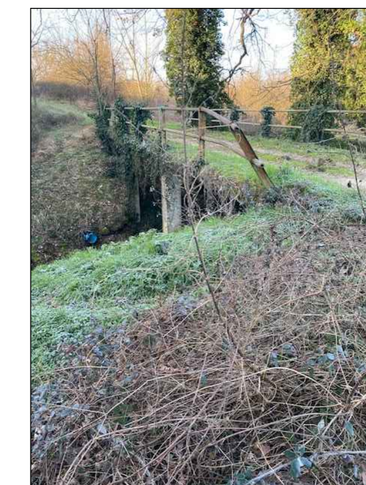
vista dalla sponda dx verso sud
