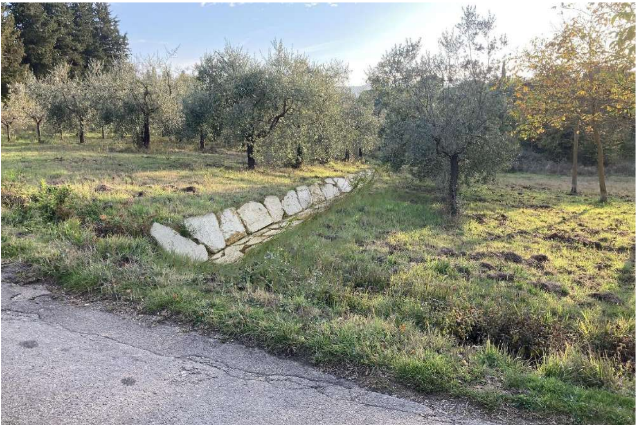
Foto 2-Prog Simulazione fotorealistica delle opere previste sul terreno agricolo posto a monte di Via Simone Martini, non ricadenti in area in cui sussiste il vincolo paesaggistico
