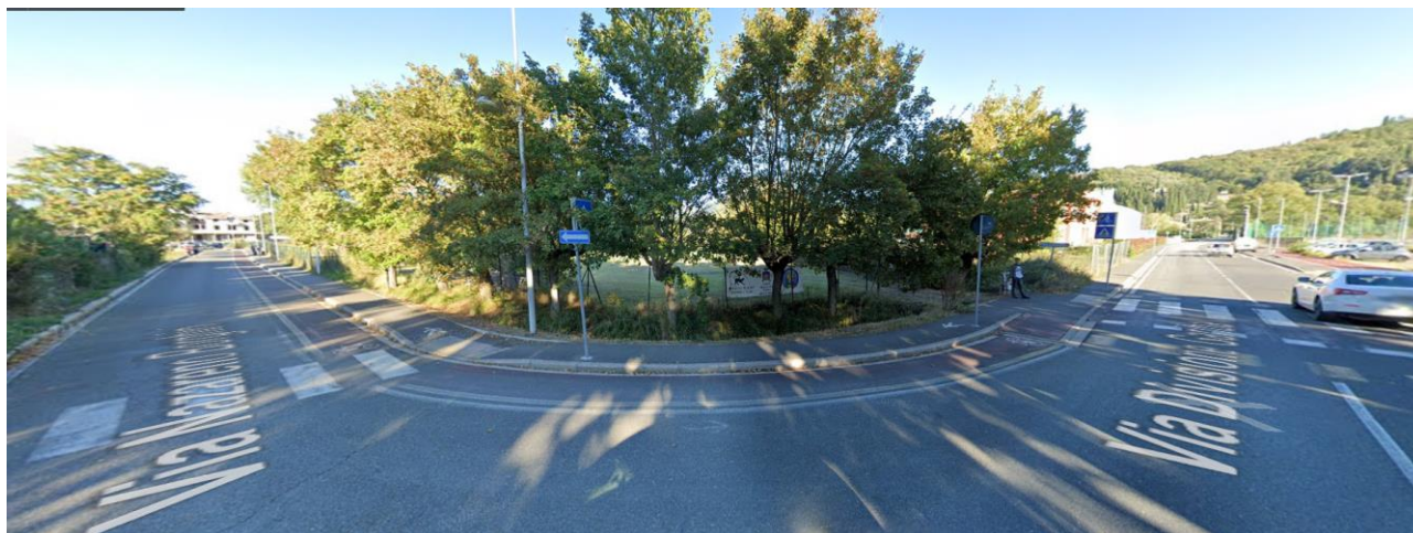
Figura 4-17 Vista in direzione dell'impianto idrovoro dall'intersezione fra via Nazareno Borghini, via Divisione Garibaldi e via di Castelsecco, che verrà occultato dalla presenza delle alberature esistenti in fregio alla viabilità locale
