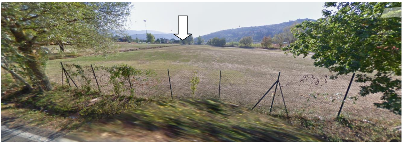
Figura 6-4 Vista in direzione dell'impianto idrovoro da via Nazareno Borghini (la cui ubicazione è indicata con la freccia). La distanza contribuirà a ridurre la percezione visiva per l'evidente effetto prospettico, nei punti in cui non sono presenti essenze arboree in fregio alla viabilità
