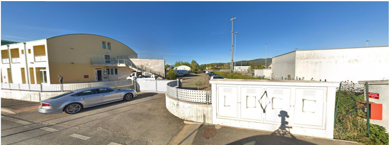
Figura 6-3 Vista in direzione dell'impianto idrovoro dall'ingresso all'Arezzo Sport College lungo via di Castelsecco, che verrà occultata dalla presenza degli edifici esistenti
