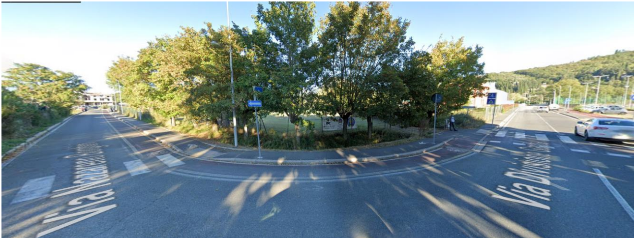
Figura 6-2 Vista in direzione dell'impianto idrovoro dall'intersezione fra via Nazareno Borghini, via Divisione Garibaldi e via di Castelsecco, che verrà occultata dalla presenza delle alberature esistenti in fregio alla viabilità locale
