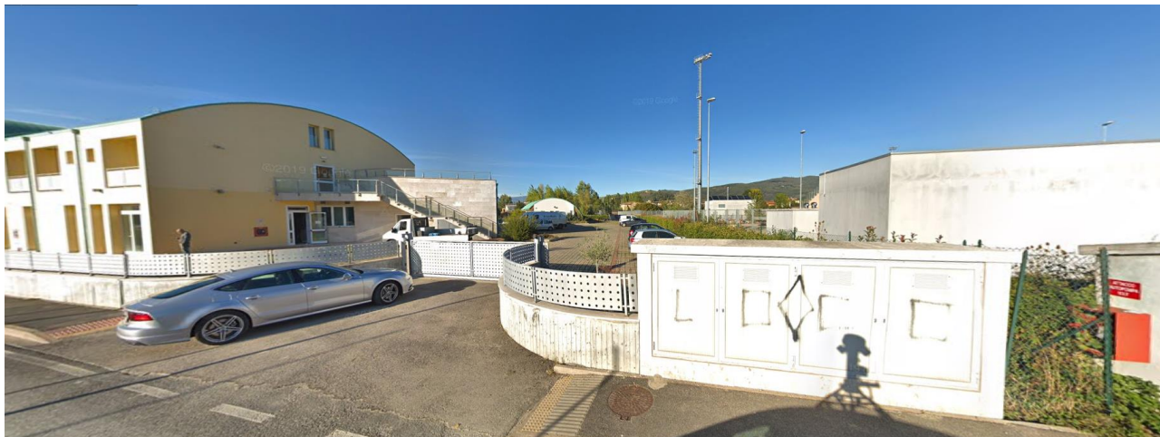
Figura 4-18 Vista in direzione dell'impianto idrovoro dall'ingresso all'Arezzo Sport College lungo via di Castelsecco, che verrà occultata dalla presenza degli edifici esistenti
