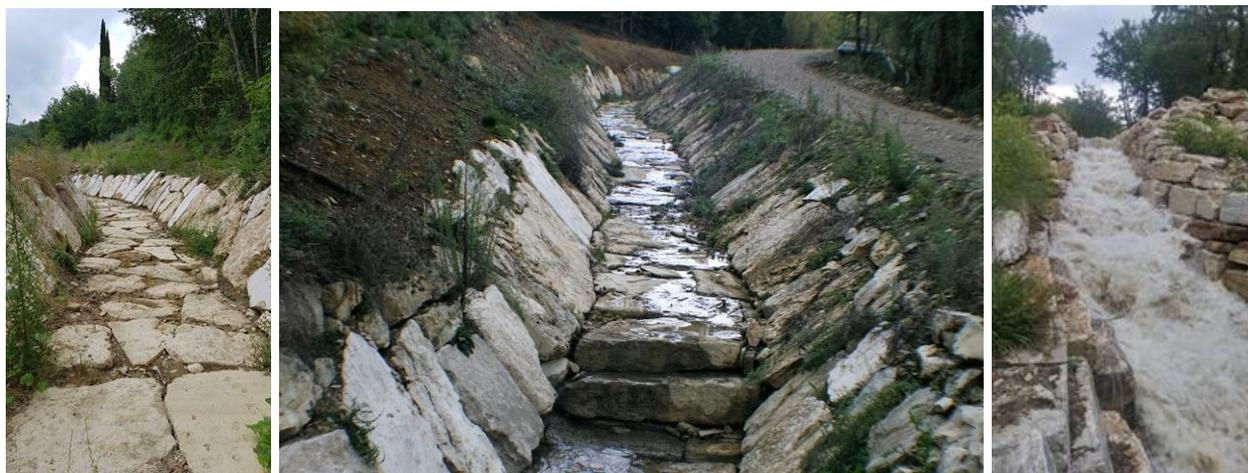
Figura 4-5: Esempio di realizzazione di un alveo a sezione trapezia rivestita in blocchi di pietra.
