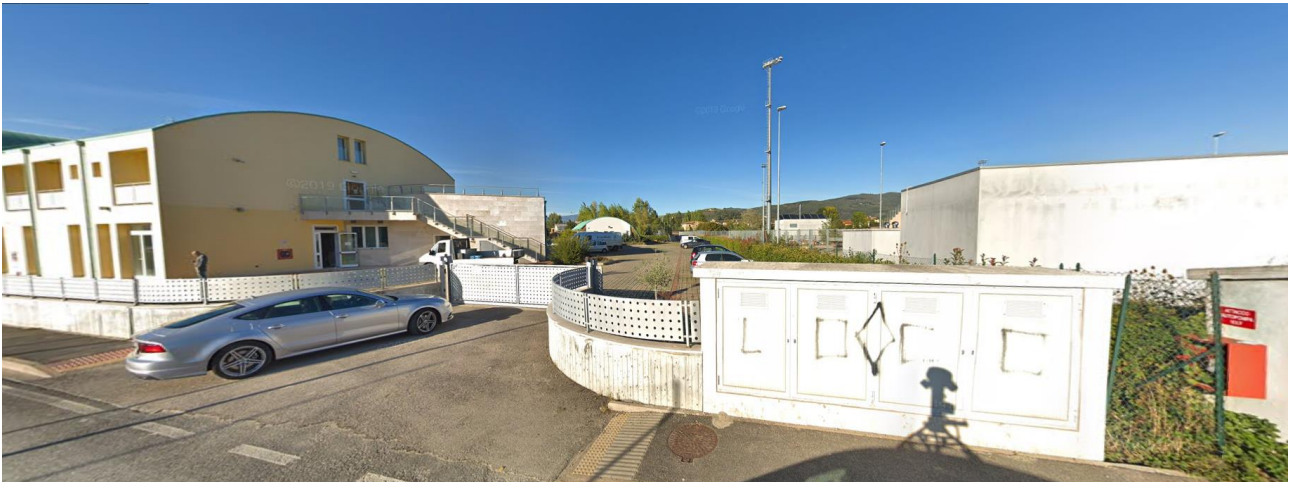
Figura 3-13 Vista in direzione dell'impianto idrovoro dall'ingresso all'Arezzo Sport College lungo via di Castelsecco, che verrà occultata dalla presenza degli edifici esistenti
