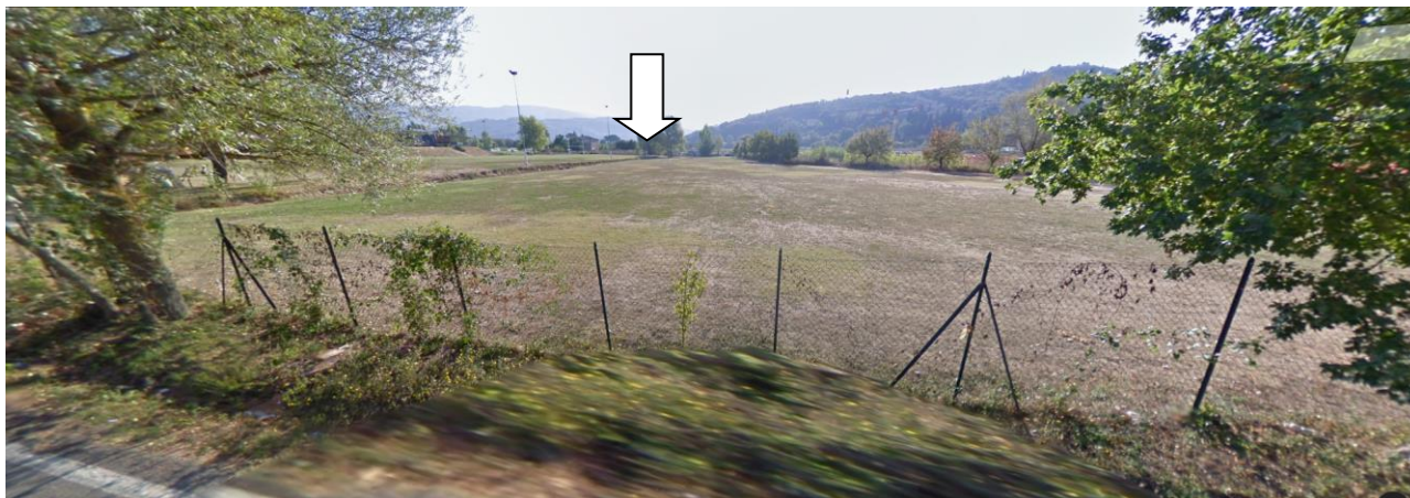
Figura 3-14 Vista in direzione dell'impianto idrovoro da via Nazareno Borghini (la cui ubicazione è indicata con la freccia). La distanza contribuirà a ridurre la percezione visiva per l'evidente effetto prospettico, nei punti in cui non sono presenti essenze arboree in fregio alla viabilità
