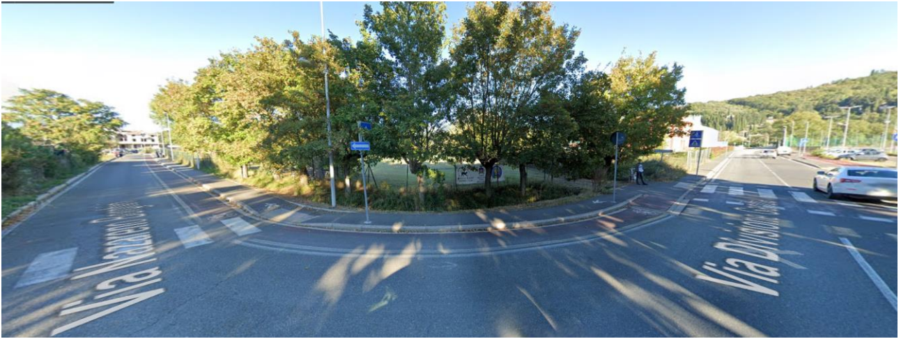
Figura 3-12 Vista in direzione dell'impianto idrovoro dall'intersezione fra via Nazareno Borghini, via Divisione Garibaldi e via di Castelsecco, che verrà occultata dalla presenza delle alberature esistenti in fregio alla viabilità locale
