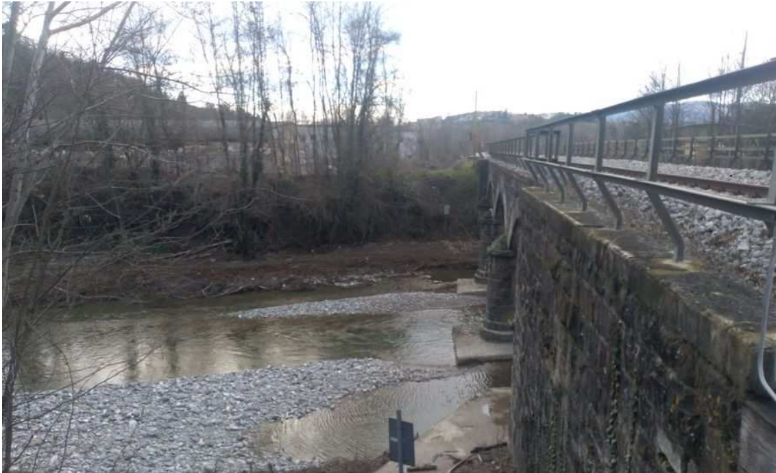
Passerella su Torrente Corsalone: situazione esistente
