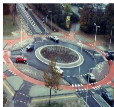
Rotatoria con ciclabile esterna
