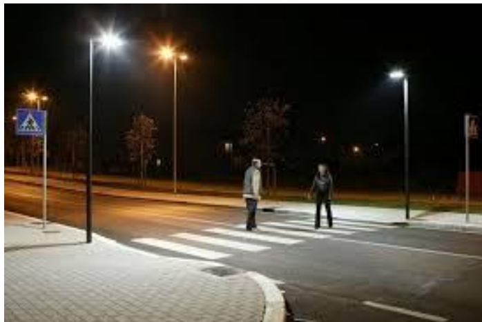
Illuminazione artificiale dei passaggi pedonali
