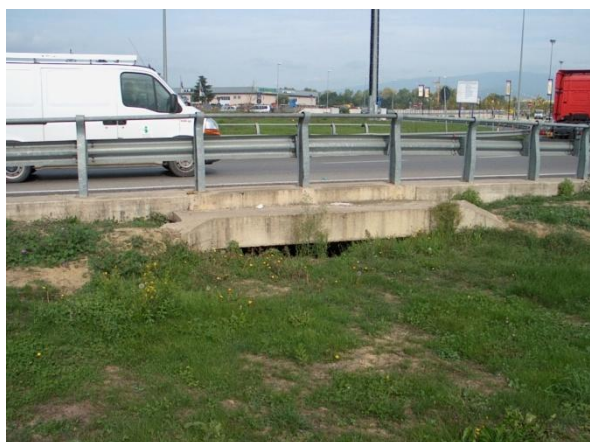
Rotatoria Setteponti: opere d'arte già realizzate, attualmente interrato
