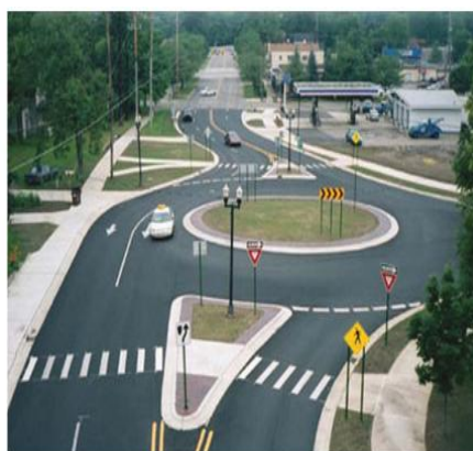
Rotatoria con ciclabile esterna
