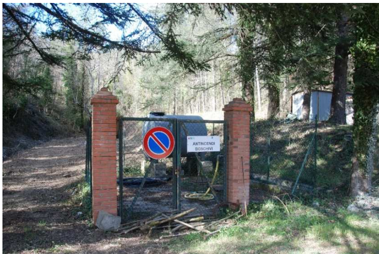
Complesso Alpe di poti – cisterna Aib Loc. Scopetone
