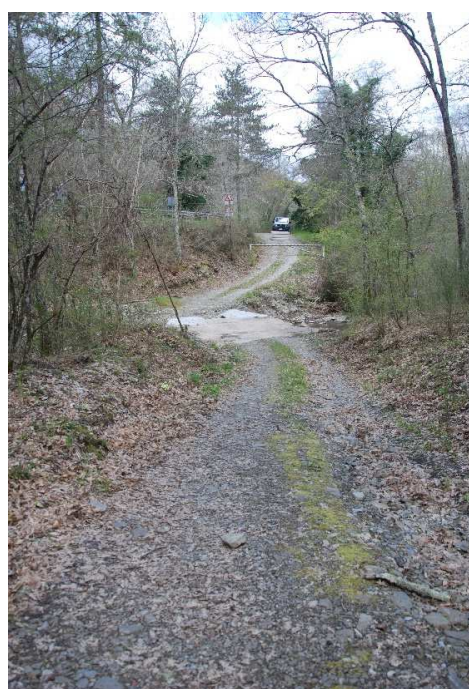
Complesso Alpe di poti – Interdizione alla strada forestale con sbarra e dissuasori in cemento In loc. Torrente Cerbone
