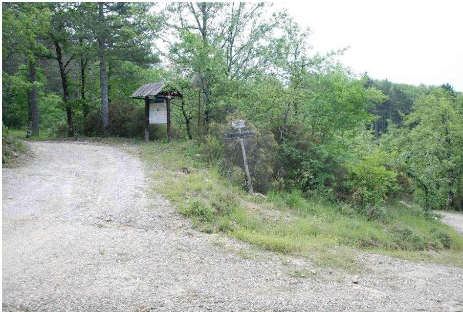
Complesso Alpe di Poti- Settore Ranchetto – Strada forestale in prossimità Del limite del complesso in loc. Lagnano
