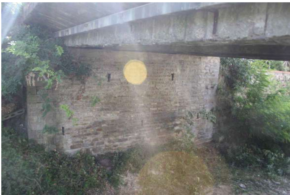
FOTO 8 - Spalla sinistra - Vista lato monte
