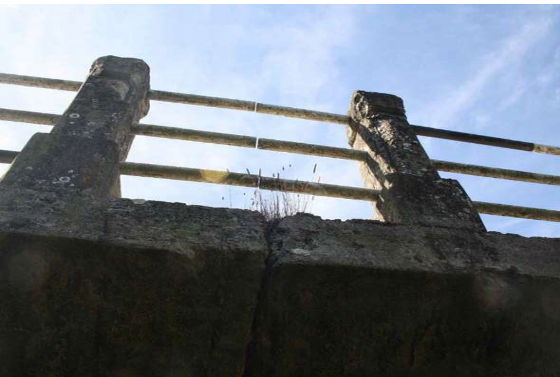
FOTO 6 - Particolare del giunto tra gli impalcati
