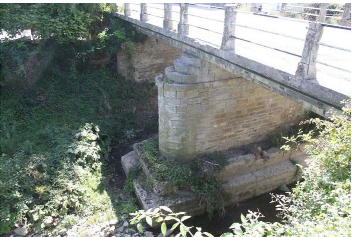
FOTO 9 - Pila - Vista lato monte
