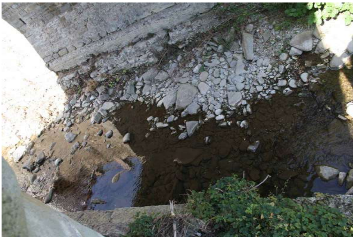
FOTO 5 - Vista alveo del Torrente Chiassa
