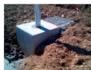
Plinto di fondazione per palo illuminazione in acciaio
