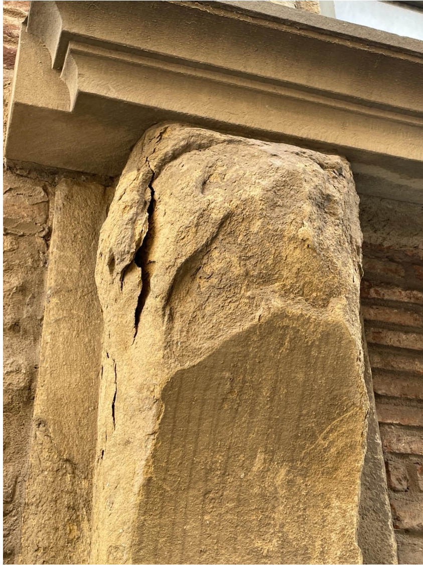
Dettaglio della scagliatura nelle volute delle mensole delle edicole
