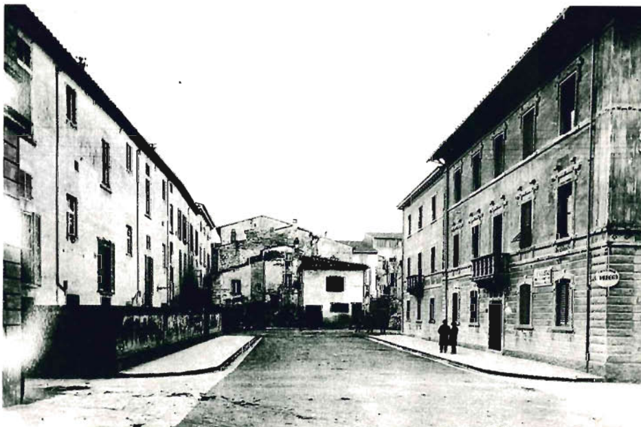
In alto: Anni venti. Non sono iniziati restauri posiccici sugli edifici monumentali Sopra: Via Roma anni Venti. A sinistra l'ospedale, sullo sfondo manca ancora il collegamento al Corso (fototeca E.P.T. Arezzo)
